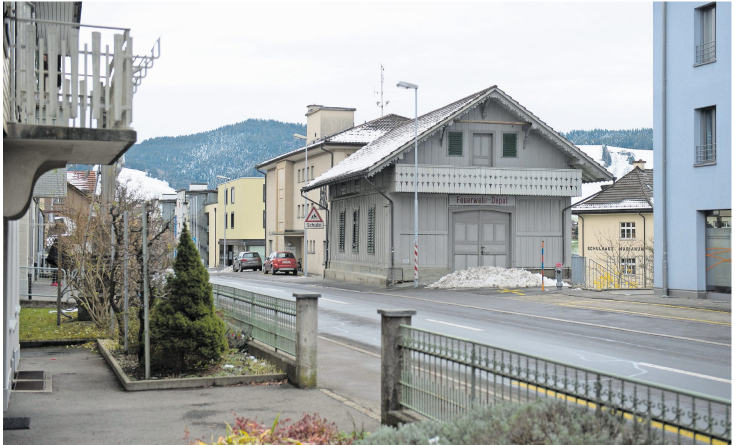
Im Spritzenhaus sind einige Sanierungen nötig.
