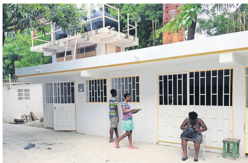
Auf der grossen Deckenplatte der Schulzimmer soll der neue Schlafraum gebaut werden. Die Schulzimmer wurden ebenfalls mit Spendengeldern gebaut.
